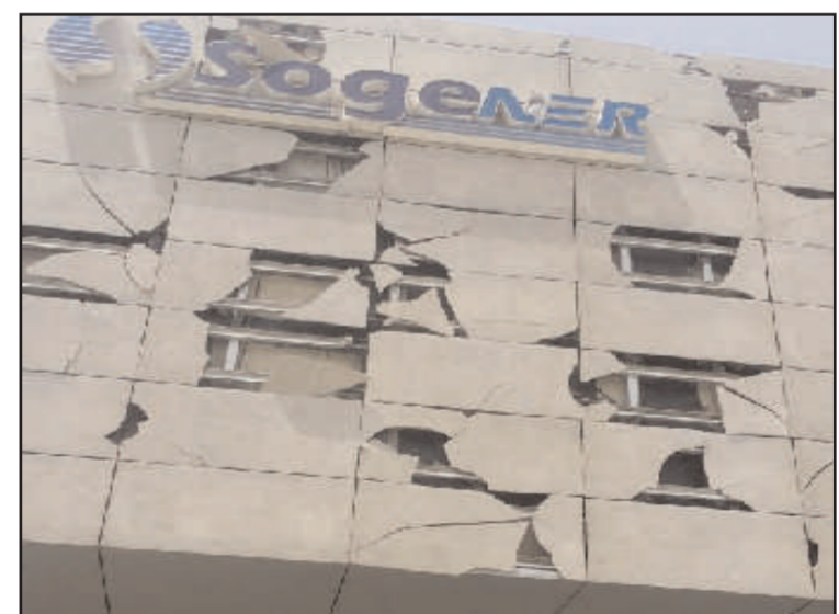
La façade de la Sogebank.
